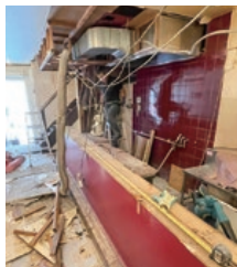
三枝さんは工事も立ち合い監修。右は改装のコンセプト図面。
